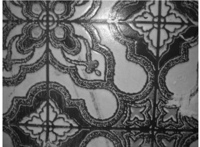
Teli a triplo strato con cartone di amianto, foto: Carbotech AG
