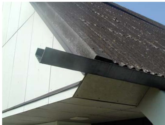
Toiture ondulée en fibrociment
