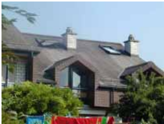
Tuiles en fibrociment
