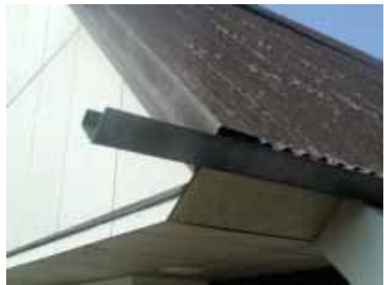
Toiture ondulée en fibrociment
